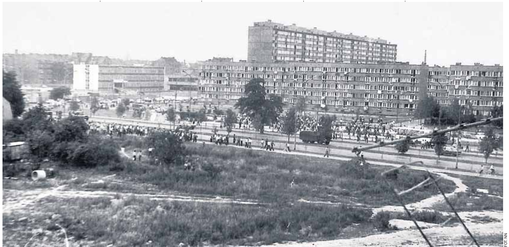
Protestujący zmierzający na plac budowy kościoła. Fotografia wykonana z bloku przy ul. Heweliusza w Legnicy (zbiory Wojciecha Obremskiego)
